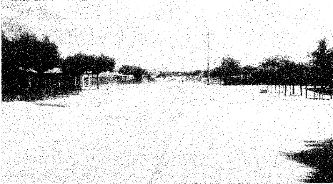
RUA S/ DENOMINAÇÃO OFICIAL 01
