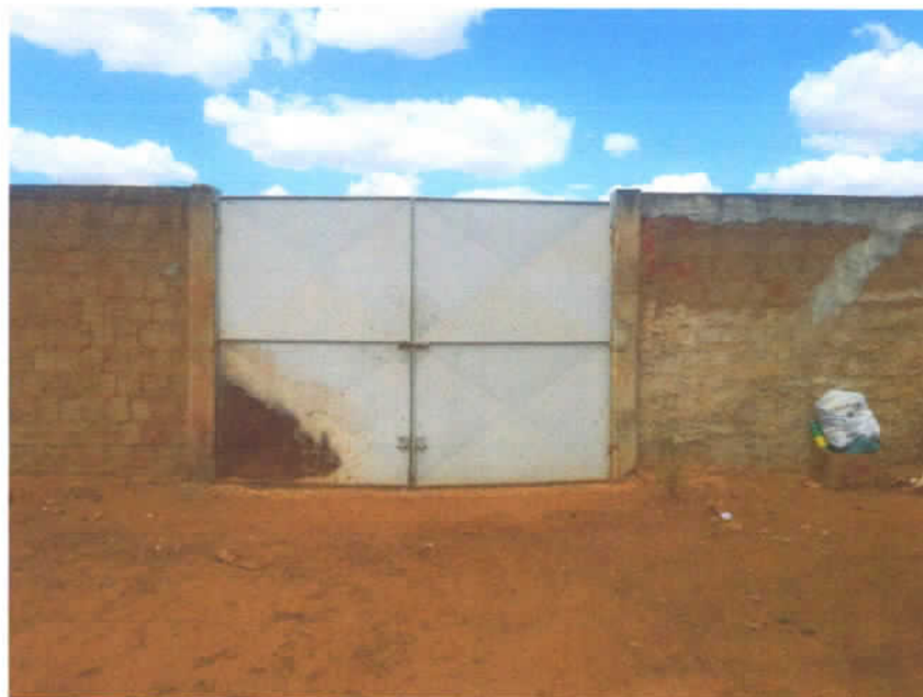
FOTO -03 (PORTÃO DE ENTRADA)
