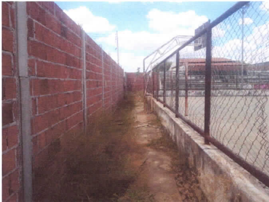
FOTO -04 (VISTA CORREDOR FUNDO DE QUADRA)
