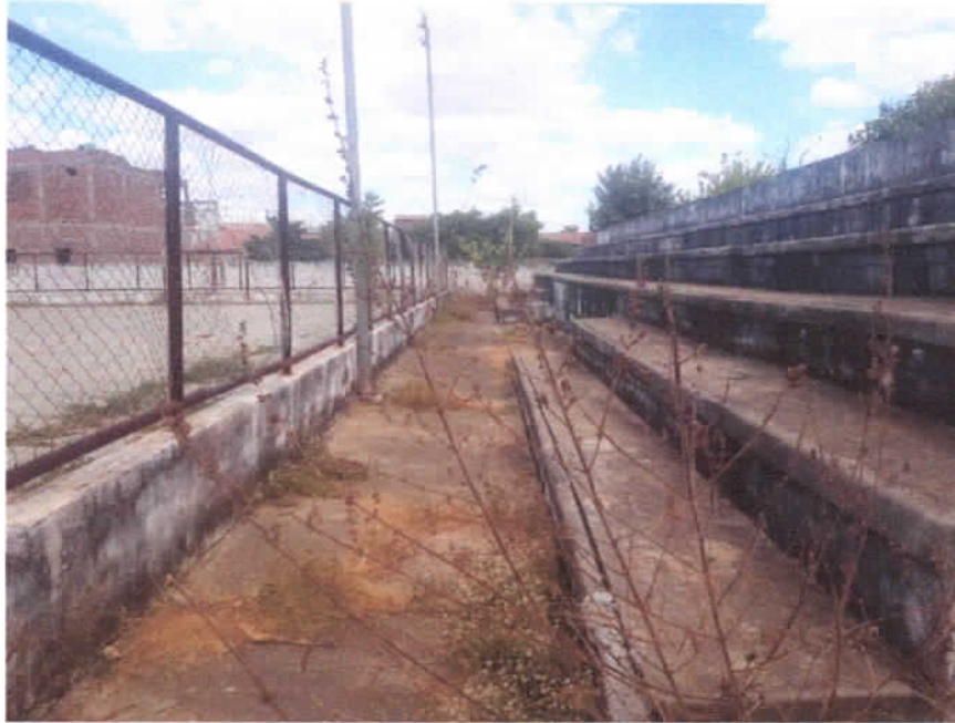
FOTO -01 (VISTA GERAL DA ARQUIBANCADA)
