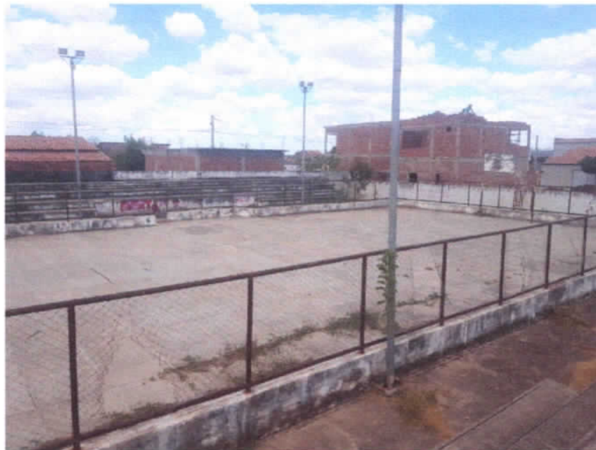
FOTO -02 (VISTA GERAL DA QUADRA)
