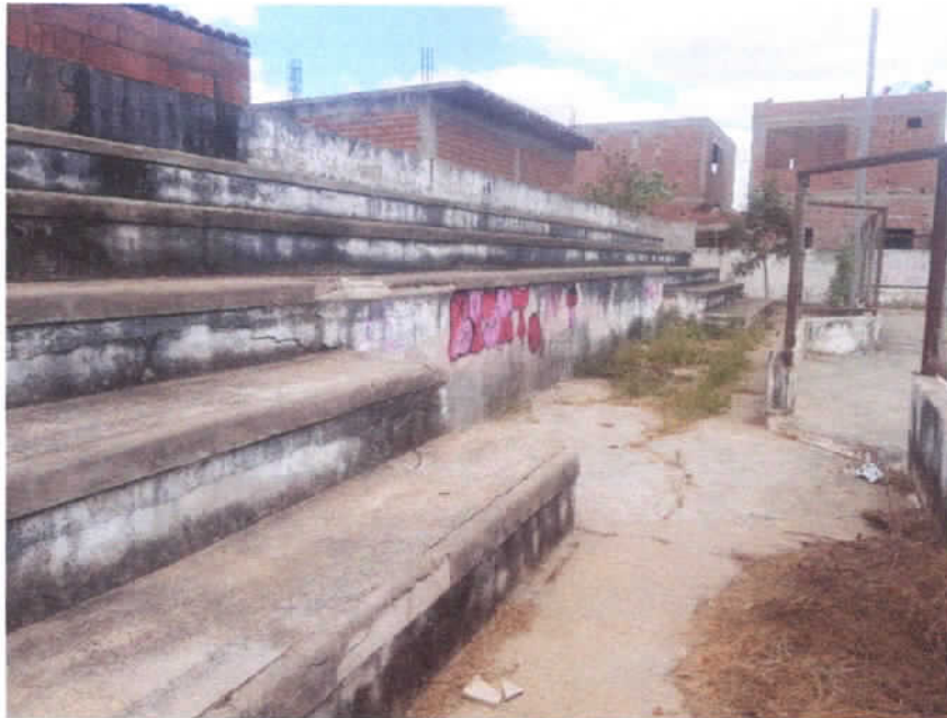
FOTO -03 (VISTA GERAL DA ARQUIBANCADA)
