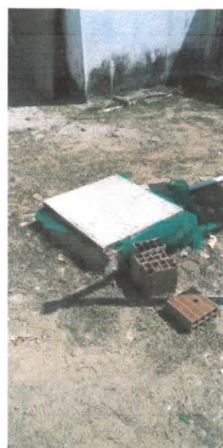
Imagem 1 – Sistema atual de tratamento fossa-sumidouro. Sobre esse sistema a ETE projetada deverá ser construída.
