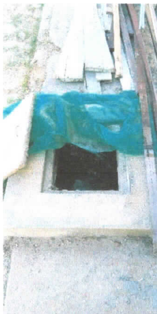
Imagem 4 – Caixa de passagem aberta.
