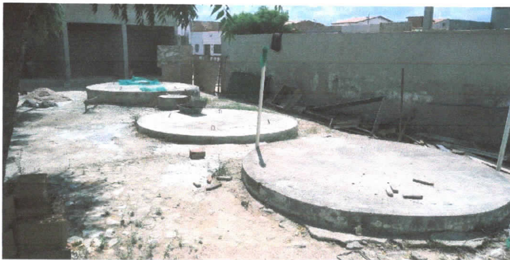
Imagem 1 – Sistema atual de tratamento fossa-sumidouro. Sobre esse sistema a ETE projetada deverá ser construída.
