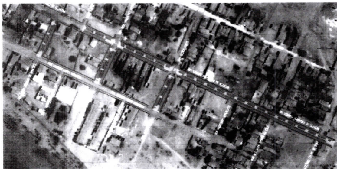
RUA HADOQUE COSTA
