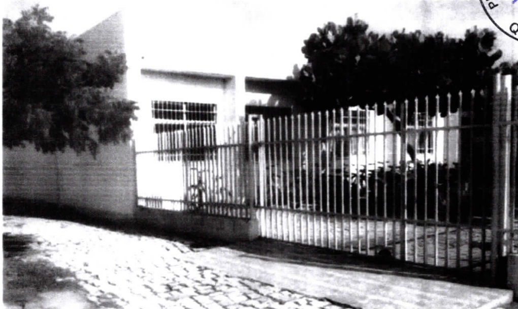
FOTO 02 (PORTÃO DE ENTRADA ESCOLA)
