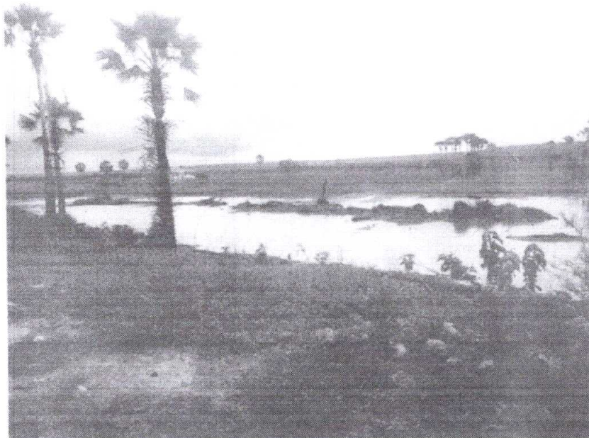
FOTO 02 – Barragem de Contenção – Espelho d'água
