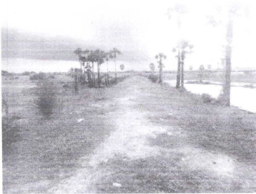
FOTO 01 – Barragem de Contenção
