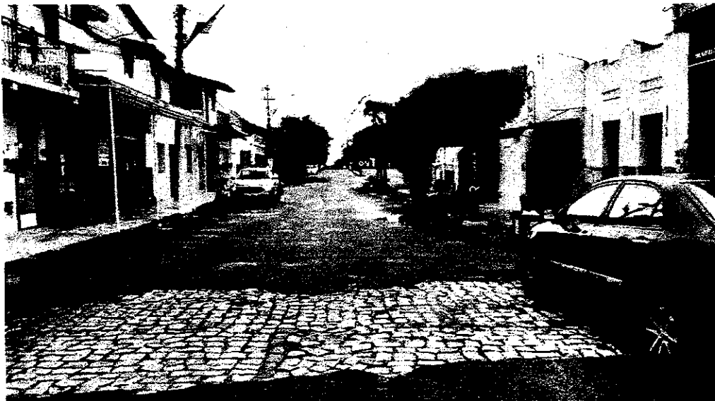
RUA MANOEL GONÇALVES – TRECHO INTERMEDIÁRIO E(X) 611927.32 m, S(Y) 9439310.10 m
