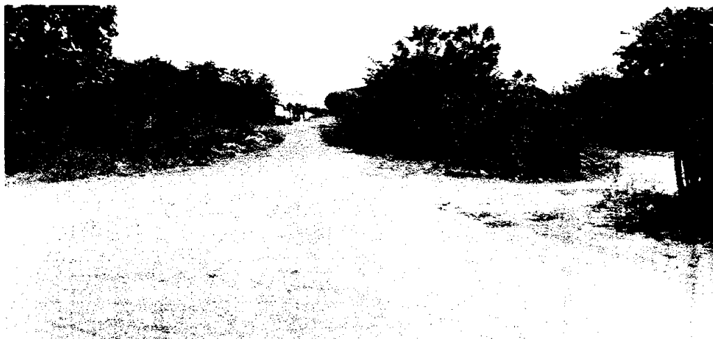
FIM DA RUA JOÃO RODRIGUES A SER PAVIMENTADO E(X) 621.380,47 m,N(Y) 9.438.004,43 m,E
