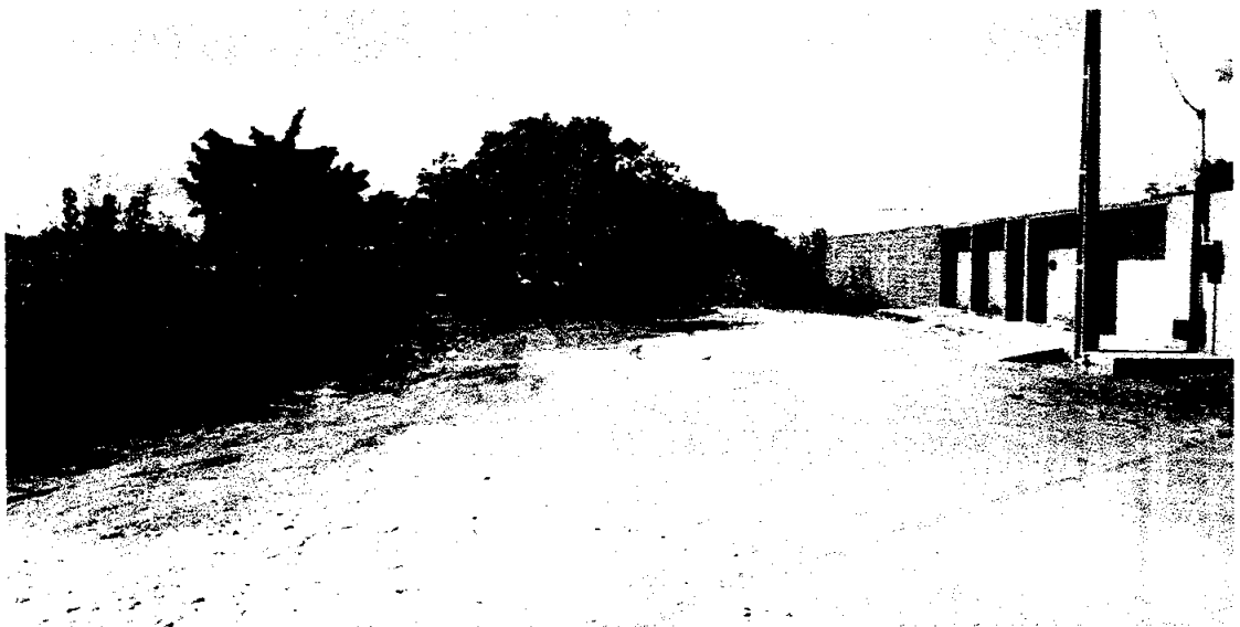
FIM DA AV. ZACARIAS FERREIRA DE SOUSA A SER PAVIMENTADO E(X) 621.283,01 m,N(Y) 9.437.732,18 m,E
