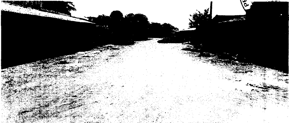
INÍCIO DA RUA PROJETADA A SER PAVIMENTADO E(X) 621.333,65 m,N(Y) 9.437.928,03 m,E
