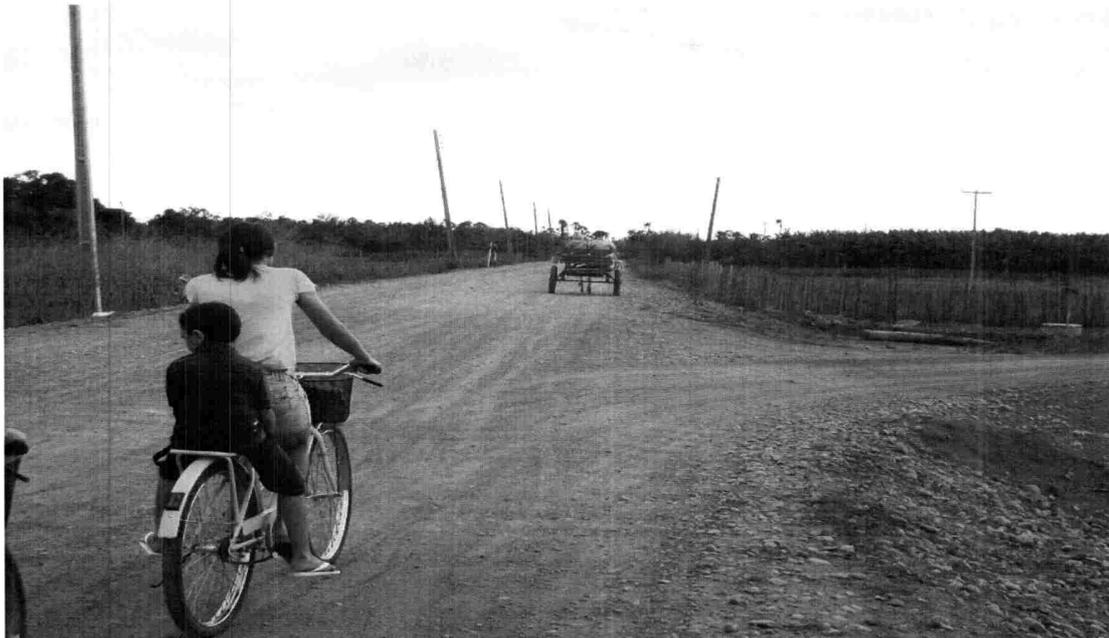
TRECHO COMPREENDIDO ENTRE AS ESTACAS 0 E ESTACA 50. VERIFICA-SE O ATERRO EXISTENTE COM REVESTIMENTO PRIMÁRIO JÁ BASTANTE DESGASTADO, NA LARGURA MÉDIA DE 6,00m, É NECESSÁRIO APENAS O DESMATAMENTO NA FAIXA LATERAL PARA MELHOARAR A VISIBILIDADE.
