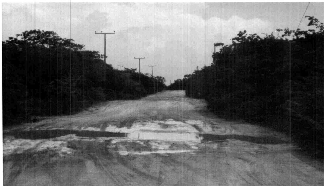
TRAVESSIA DE TALVEGUE, SEM BUEIRO. SENDO NECESSÁRIO A CONSTRUÇÃO DE BUEIROS NAS ESTACAS: 327, 480 + 15M, 513 + 11M, 558 + 7M, 597 + 3M E NO ACESSO 1 NA ESTACA 73 + 4M. . VEFICA-SE QUE A PLATAFORMA DA ESTRADA EXISTENTE É VARIÁVEL, RESOLVEU'SE CONSIDERAR UMA LARGURA DA PLATAFORMA FINAL COM 6,00M. EM ALGUNS SEGMENTOS DEVE EXECUTAR O DESMATAMENTO DA FAIXA DE DOMÍNIO.
