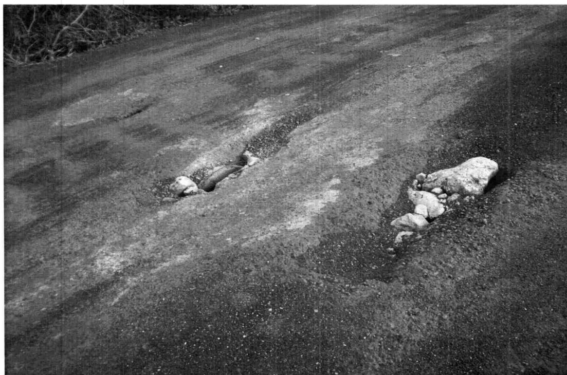
TUBOS NÃO REJUNTADO E EXPOSTO NA SUPERFÍCIE DA RODOVIA JÁ BASTANTE DANIFICADO. DEVE SER RECOBERTO POR UM ATERRO COM MAIS DE 05m DE ALTURA. DEVE SER REMOVIDO.
