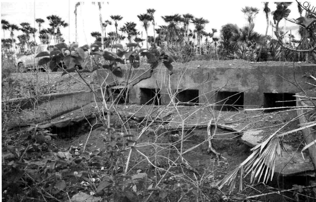
COMO DRENAGEM ARTIFICIAL FOI OBSERVADO 13 BUEIROS AO LONGO DO TRAÇADO, VERIFICA-SE QUE O ESTADO DE CONSERVAÇÃO ESTÃO PRECÁRIOS, POR EXEMPLO, BUEIRO FORA DE PADRÃO DER, CALÇADA DE PROTEÇÃO DANIFICADA, SEM MURO DE TESTA.
