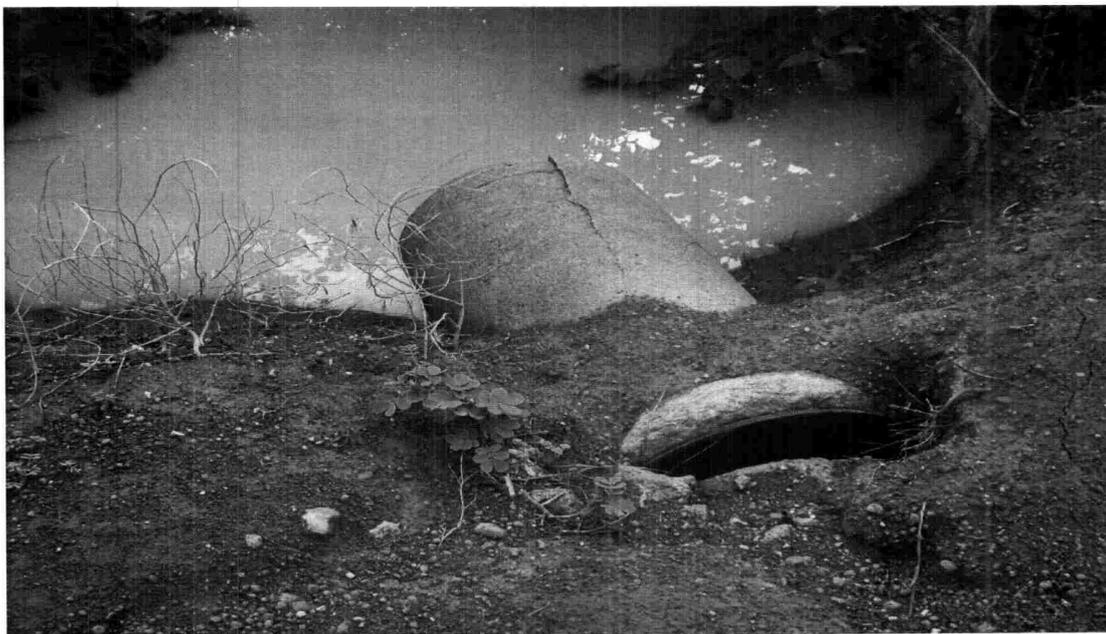
SENDO NECESSÁRIA REMOÇÃO DE 12 BUEIROS., POR EXEMPLO, BUEIRO SEM CABEÇA, TUBOS NÃO REJUNTADO E EXPOSTO NA PARTE SUPERIOR DA RODOVIA.
