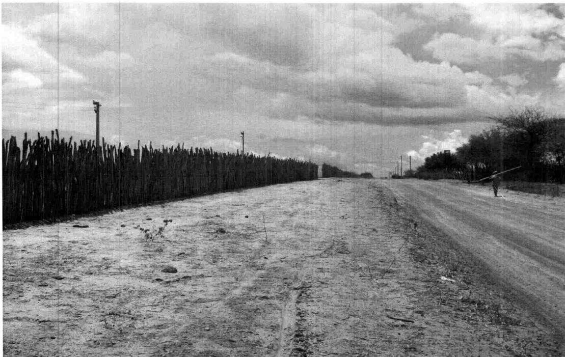
TRECHO COMPREENDIDO ENTRE AS ESTACAS 115 A 125. VERIFICA-SE A SEÇÃO DA PLATAFORMA COM TALUDE DE CORTE, É NECESSÁRIO A EXECUÇÃO DE VALETAS PARA FACILITAR O ESCOAMENTO SUPERFICIAL DAS ÁGUAS.
