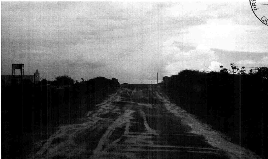
TRECHO COMPREENDIDO ENTRE AS ESTACAS 183 A 187, NO ACESSO A PONTE SOBRE RIACHO CÓRREGO DA SERRA, COM RAMPA BASTANTE ACENTUADA. SENDO NECESSÁRIO A COLOCAÇÃO DE DISPOSITIVO DE SEGURANÇA LATERAIS (DEFENSAS) PARA EVITAR A PRECIPITAÇÃO DOS VEÍCULOS DE GRANDE ALTURA.
